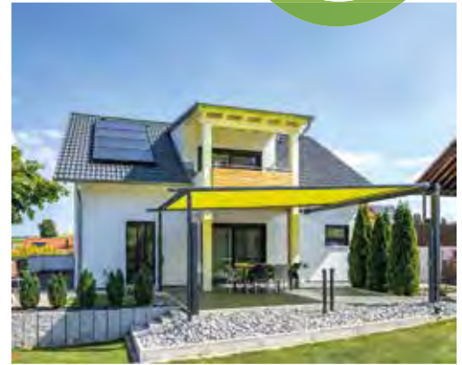
Die elektrische Energie für den Betrieb von Wärmepumpe & Co wird von Photovoltaikanlagen geliefert.
