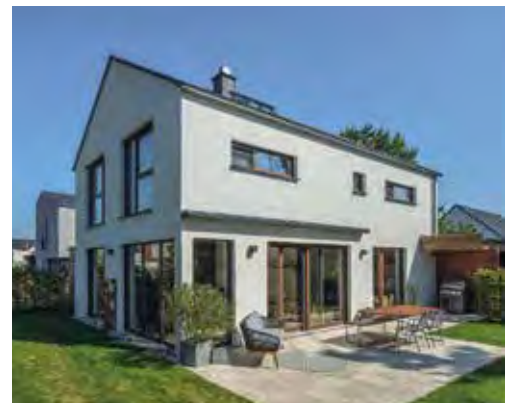
Das Effizienzhaus 40 mit Nachhaltigkeitszertifikat ist über die KfW weiterhin förderfähig.
